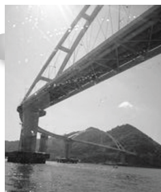
海上をカーブする『内海大橋』
